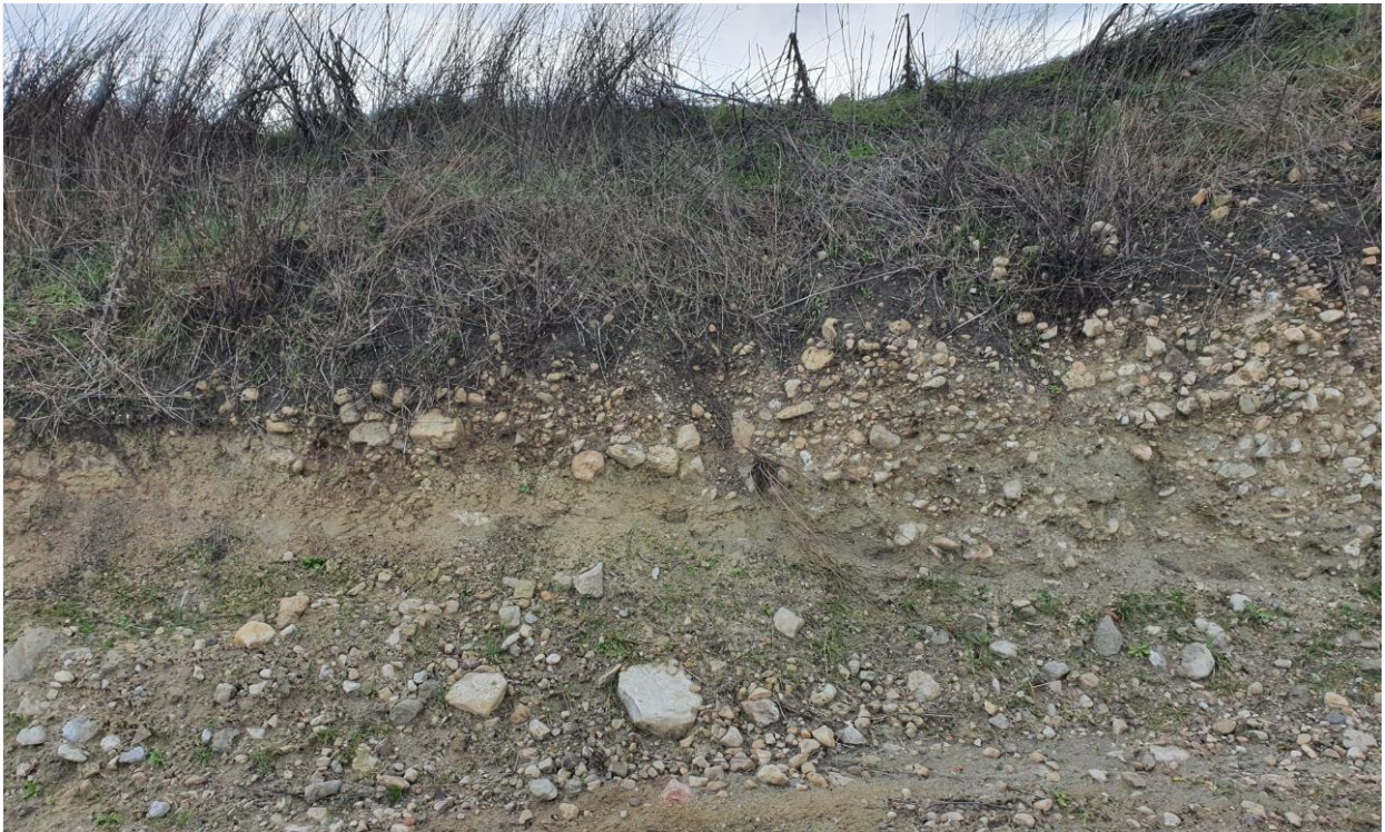
Figura 94: scavo interno, parete di scavo con suolo sovrastante e a tratti conglomerati dolomitici con al di sotto l'affioramento del livello argilloso
